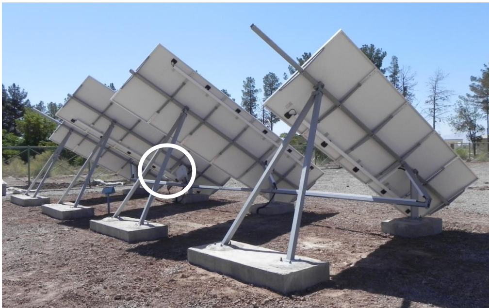
شکل : مکانیزم حرکت مربوط به سازه متحرک با ترکر (قسمت مشخص شده در شکل زیر نشان داده شده است)
