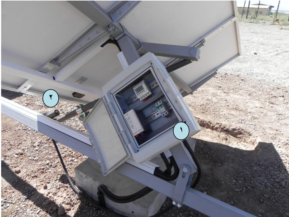
شکل : تابلوی PLC ترکر (۱) و موتور محرک آن (۲)
