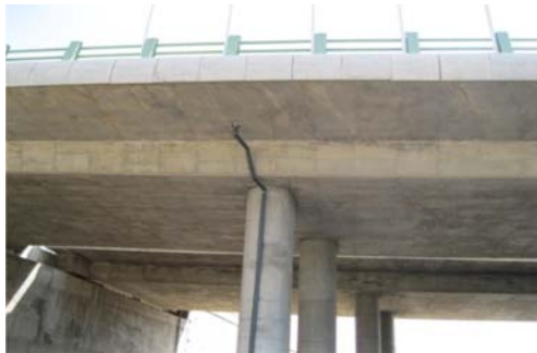
شکل 4-8- دیواره و سقف بتونی یکی از پل‌ها
