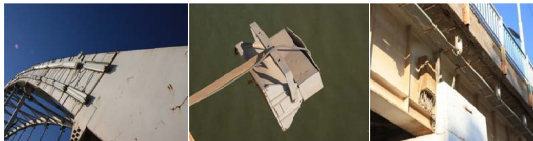
شکل 3-6- نمایی از تجهیزات روشنایی و نورپردازی موجود پل شهید جهان‌آرا
