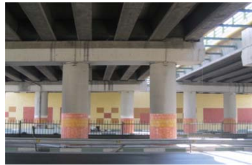
شکل 4-1- دیوارپوش کامپوزیت یکی از پل‌های شهر تهران
