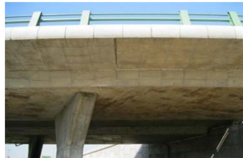
شکل 4-7- دیواره سقف بتونی یکی از پل‌ها
