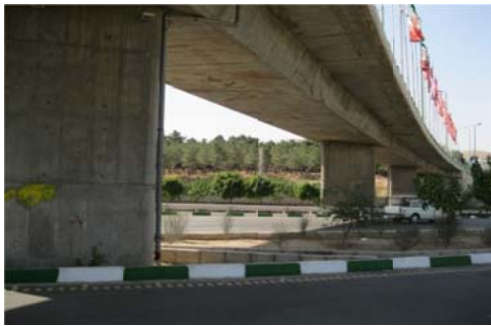
شکل 4-2- ستون بتونی یکی دیگر از پل‌های شهر تهران
