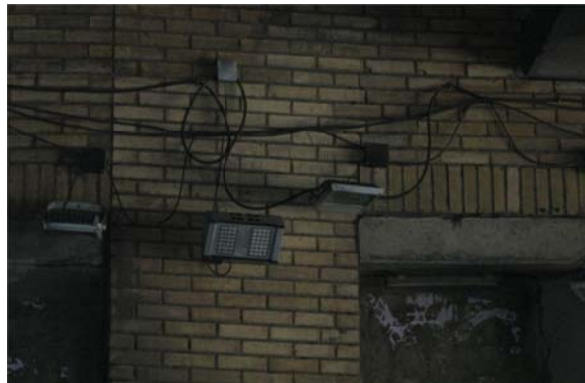
شکل 2-5- نمایی از کابلکشی نامناسب برای تغذیه روشنایی و نورپردازی
