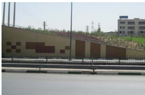
شکل 4-10- دیواره کامپوزیت پل شهید بروجردی
