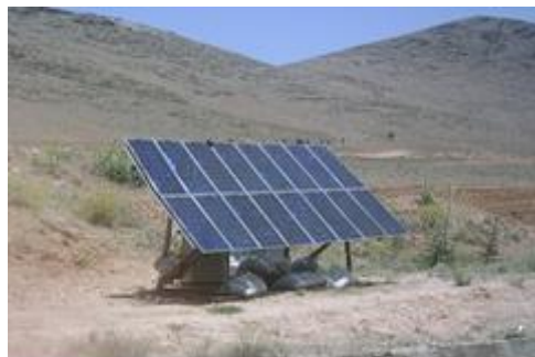
شکل ۱- نمایی از سامانه خورشیدی تامین برق مورد نیاز پمپاژ آب باغات
