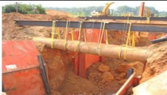
شکل ۵: نمونه‌ای از وجود تاسیسات زیرزمینی در محل گودبرداری و استفاده از حمایت کننده ۱
