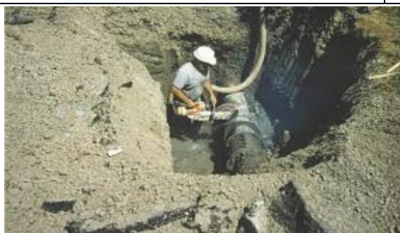
شکل ۱۰: نمونه‌ای از کار گودبرداری در حال انباشته شدن آب
