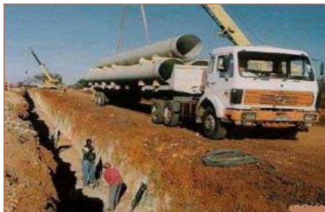
شکل ۸: نمونه ای از بارهای با پتانسیل سقوط
