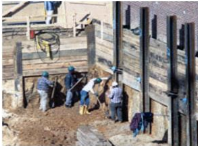
شکل ۱۱: نمونه‌ای از پایدار ساختن بنای مجاور گودبرداری
